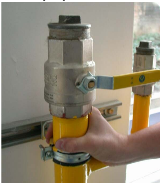
16 Anschlüsse DN50 für Gasbrenner bis 5 MW
